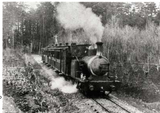
青梅鉄道の2号機関車（英国バグナル社製） （明治36年 現在の福生第一中学校付近）
