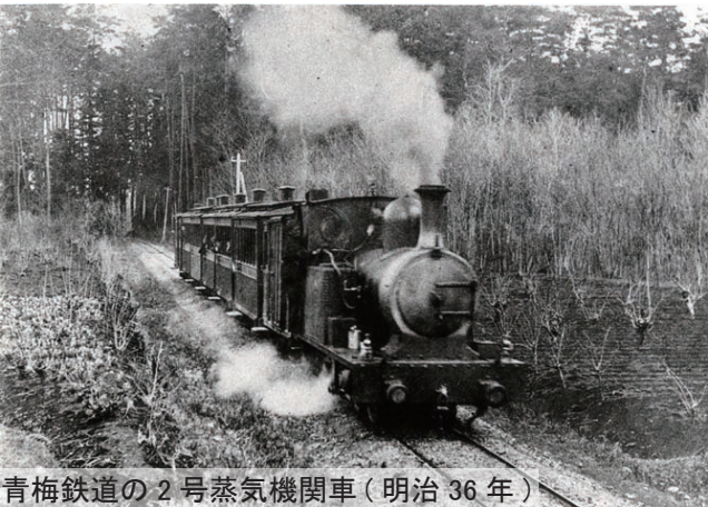
青梅鉄道の2号蒸気機関車（明治36年）
